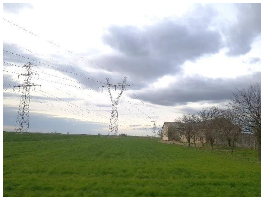
Zdj. 7. Napowietrzne linie elektroenergetyczne w pobliżu zabudowy (kwiecień 2025) Źródło: D. Czajkowski
